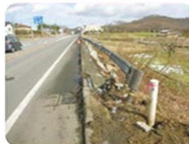
ガードレール・ 標識等の損傷
