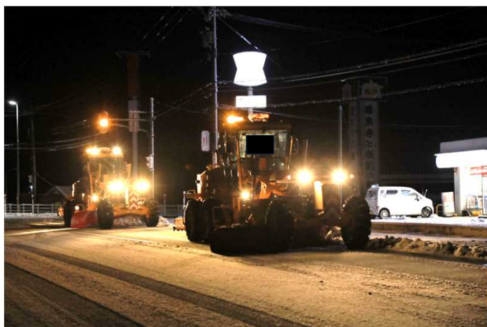
国道156号 砺波市庄川町示野地内
