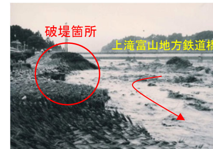
岩嶺野地先破堤状況
