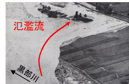
破堤状況(入善町福島地先)
