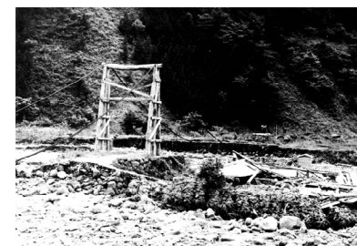
平湯川村上橋流失
