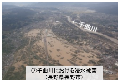
【令和元年東日本台風】
