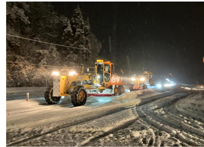
R8_津幡町舟橋 除雪の様子
