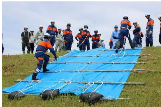
シート張り工
