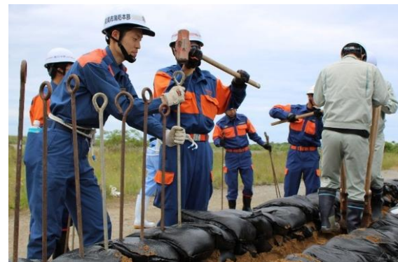
積み土のう工
