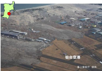
津波による被災状況 (H23.3 宮城県名取市)
