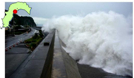
台風による越波状況 (H24.6 高知県高知市)
