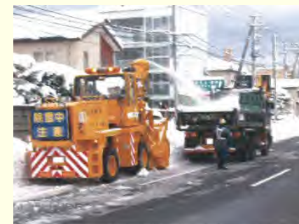
運搬排雪作業状況
