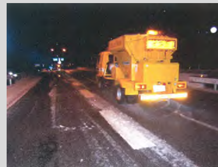
凍結防止剤散布状況
