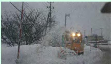
歩道除雪作業状況
