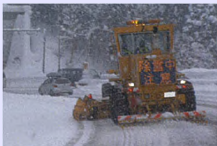
路面整正作業状況
