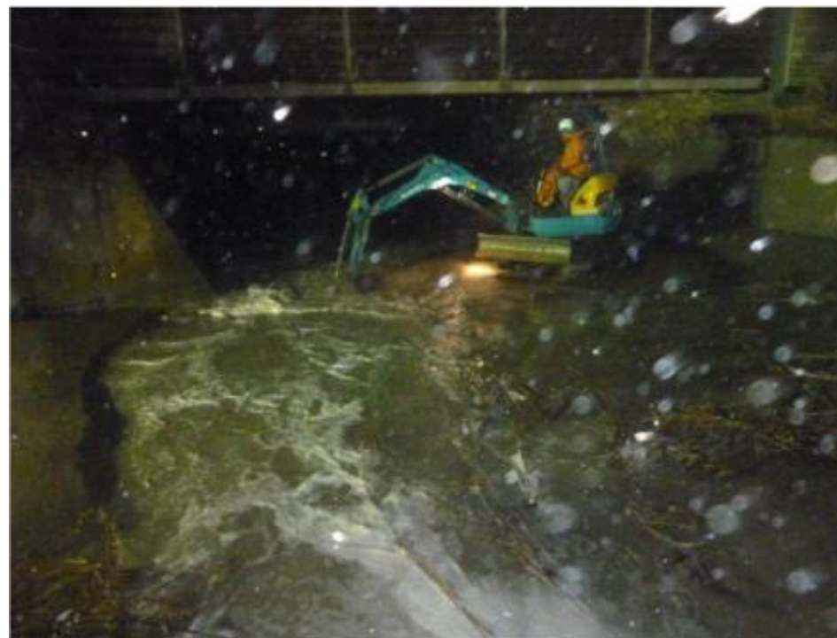
H26.12.2 地元土木会社による夜間河口土砂の掘削作業
