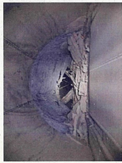
①中屋トンネル区 (地震被災状況 R6. 1)
