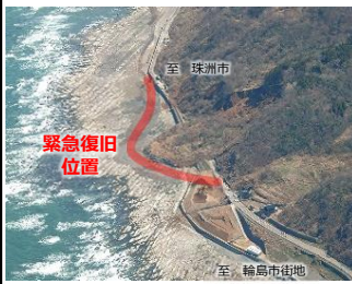
②千枚田工区 (地震被災状況 R6. 1)
