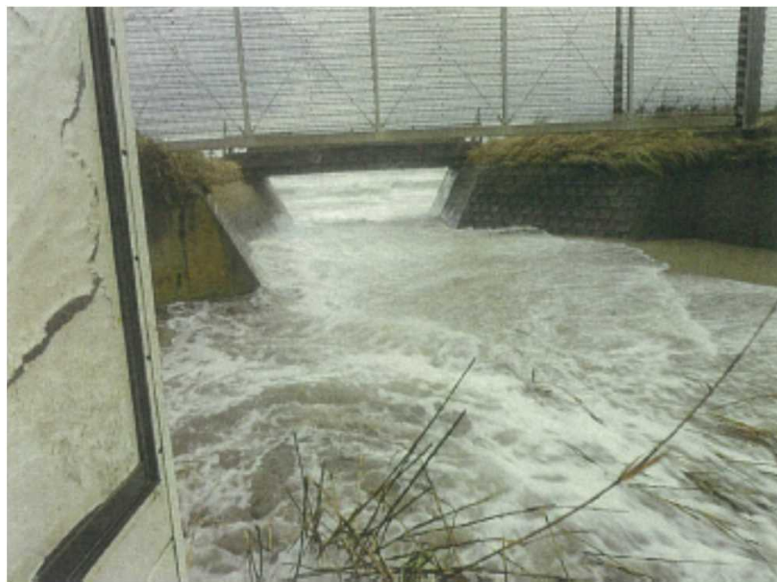
H26.12.2 河口付近 波の遡上(奥が海岸域)
