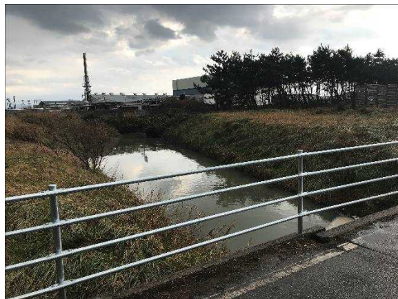
R3.11.25 巡視確認 (水路状況)
