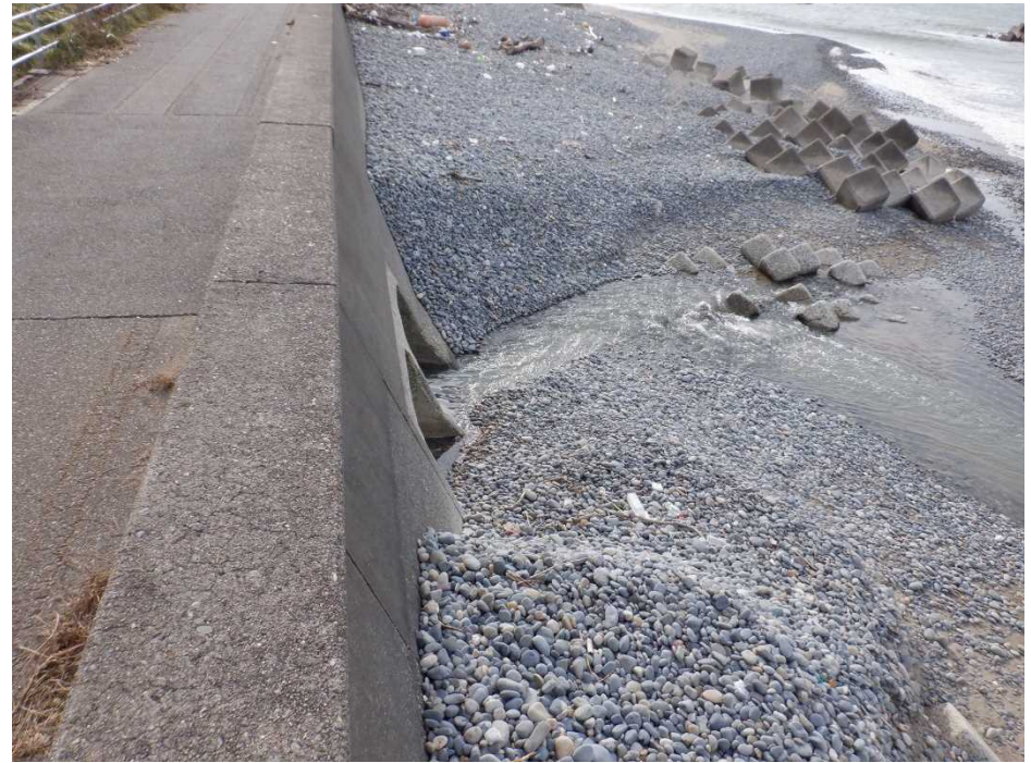
R3.11.30 巡視確認 (排水暗渠閉塞解消)
