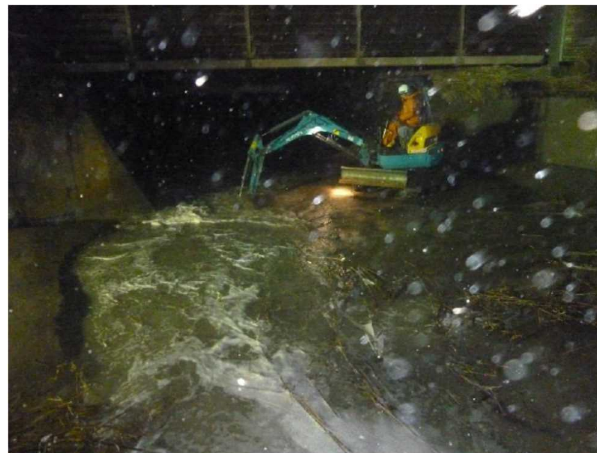
H26.12.2 地元土木会社による夜間河口土砂の掘削作業
