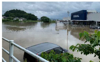
筑後川水系筑後川 (福岡県日田市)
