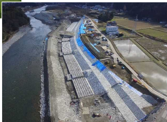
本復旧状況（令和2年2月）
