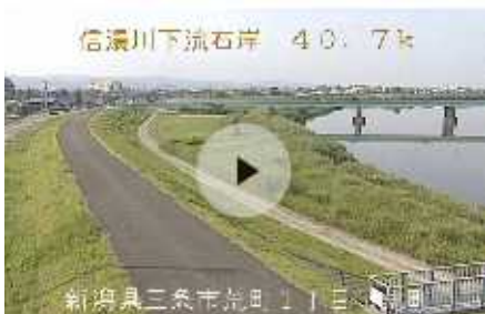
信濃川下流(カメラNo.4-36) 三条市荒町地先
