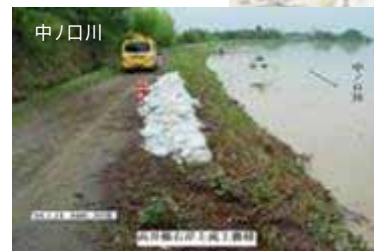
39.0kp付近 右岸 川裏 三条市石上 路肩・法面保護作業 7/14作業
