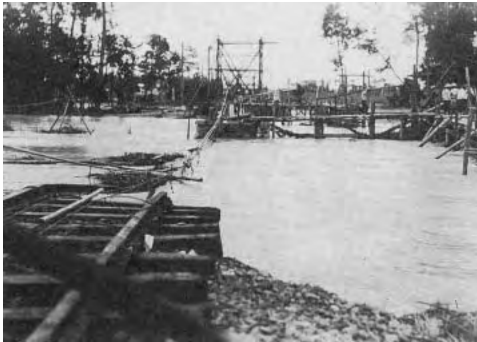
氾濫流によるJR北陸線の破壊
