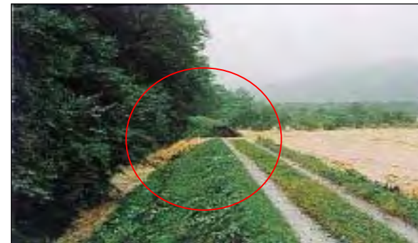
侵食発生から約30分で破堤
