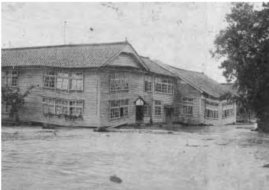
北陸線盛土の破壊により一気に流れ込んだ氾濫流により、校舎が傾いている
