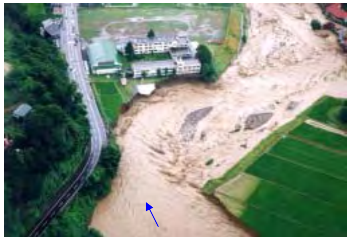
関川：平成 7 年 7 月洪水（新潟県新井市除戸地先）
