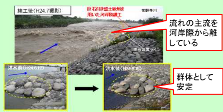
現地施工箇所の出水時・出水後の状況（H24年）
