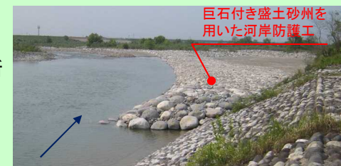
中央大学研究開発機構 福岡教授の指導の下、常願寺川をフィールドとして新たな河岸防護工を開発
