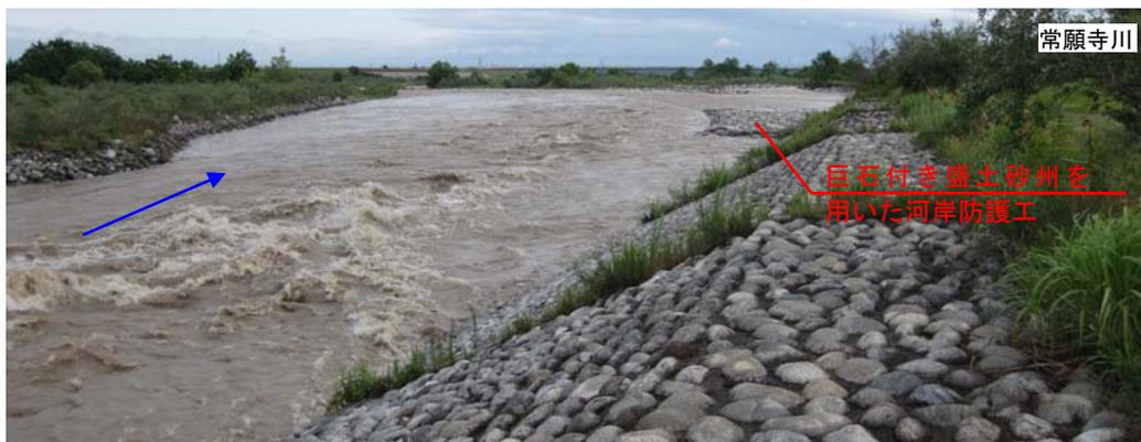
図 3.3.4 出水状況（巨石付き盛土砂州を用いた河岸防護工の天端高以下の水位）
