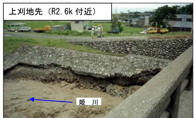
図 1.1.2 平成 7 年 7 月洪水の姫川の護岸工の被災状況
