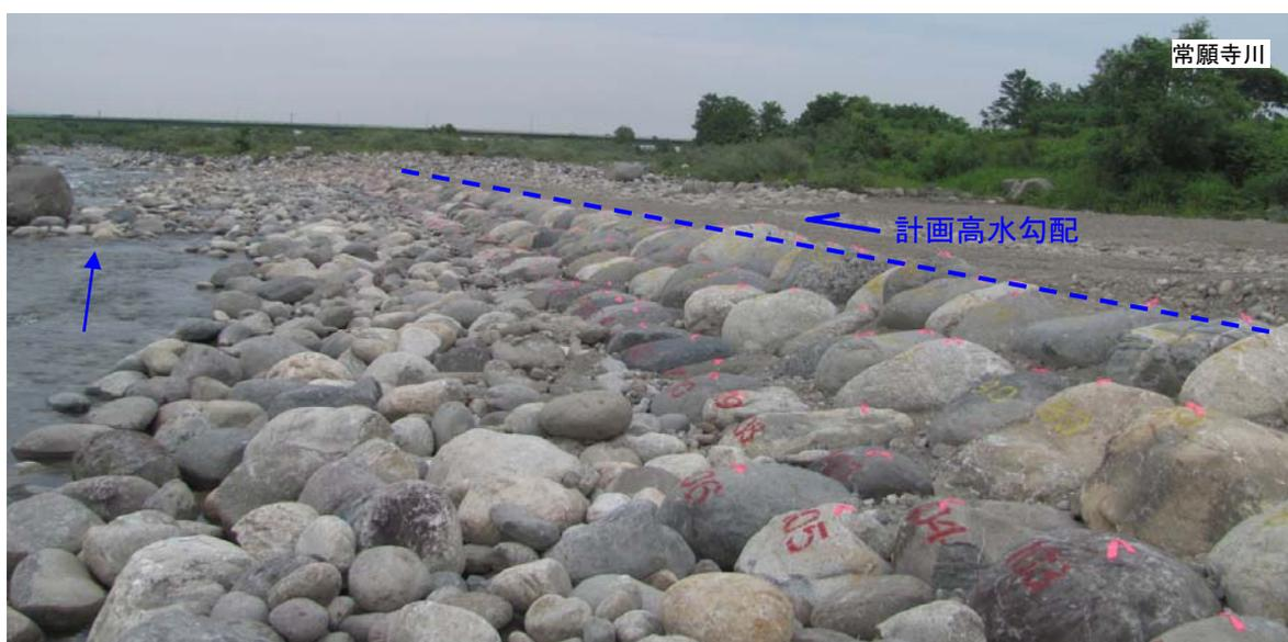
図 3.3.7 巨石付き盛土砂州を用いた河岸防護工の縦断勾配の設定例（常願寺川右岸 13.5k）
