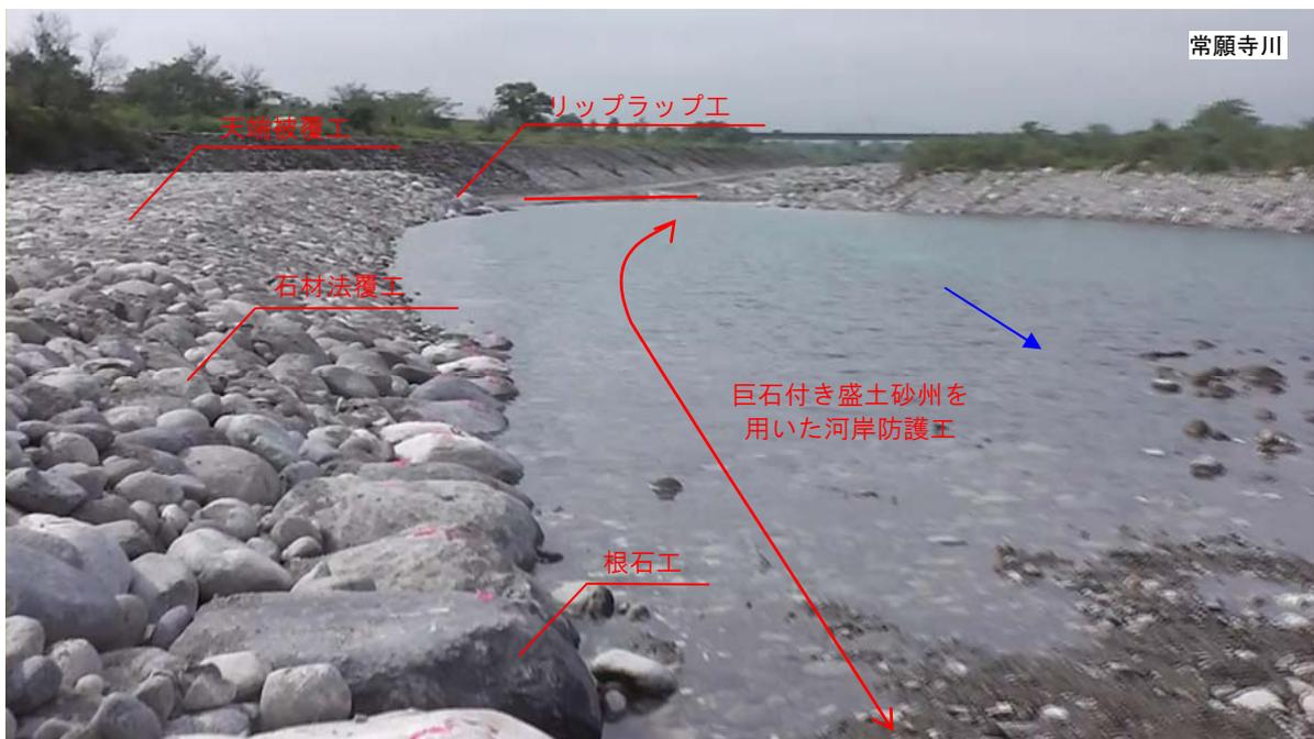
図 3.3.3 巨石付き盛土砂州を用いた河岸防護工（常願寺川右岸 11.7k）
