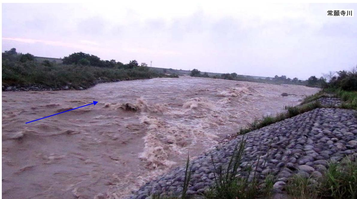
図 3.3.16 巨石付き盛土砂州を用いた河岸防護工施工地点の洪水時の様子
