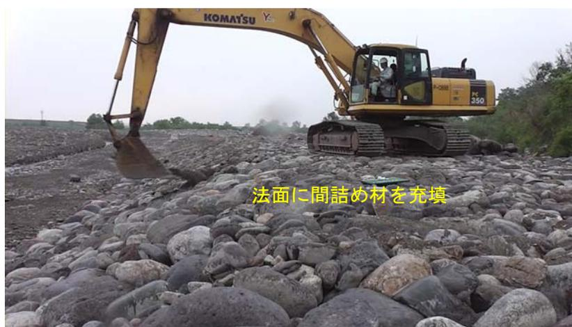
図 3.3.29 石材法覆工の間詰め施工状況
