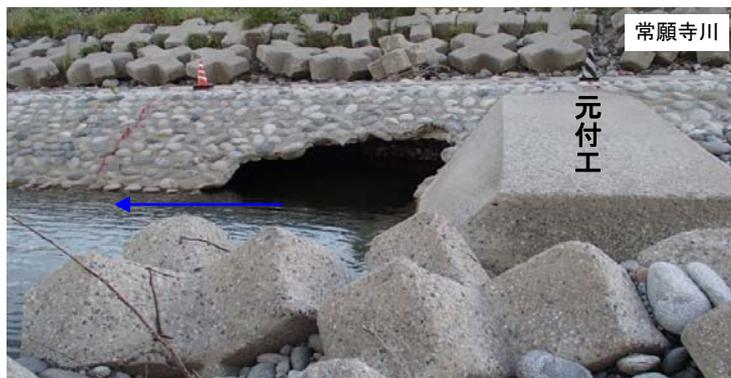
護岸の元付工直下流において護岸の損傷が見られた
