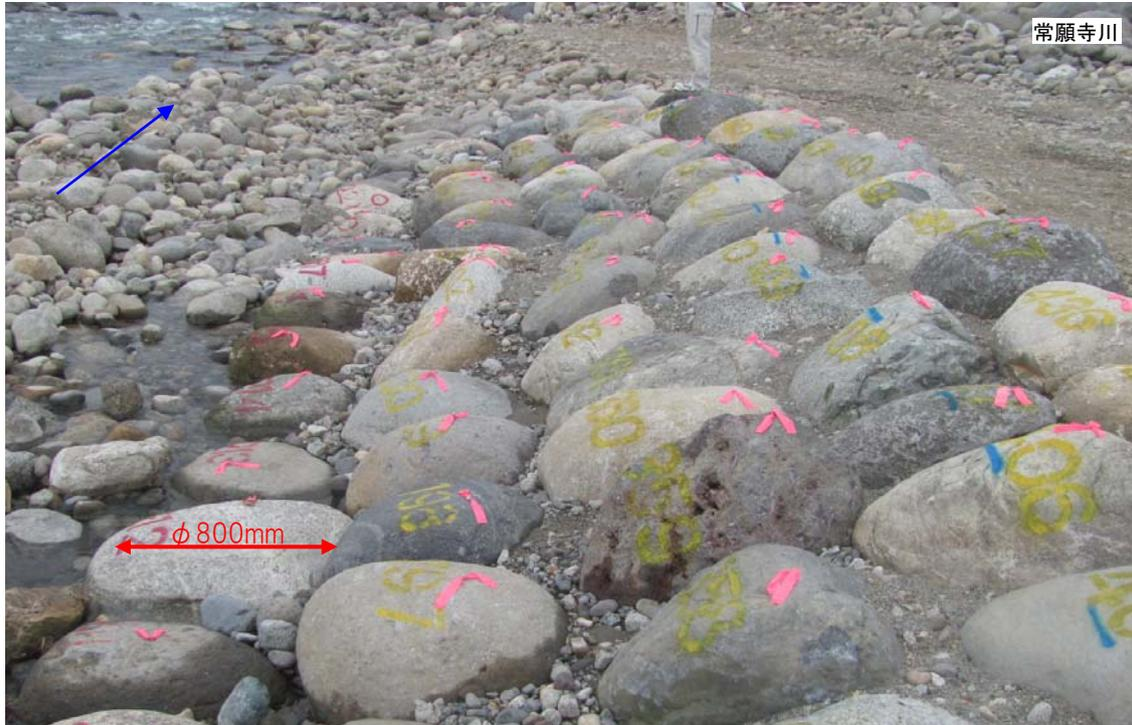
図 3.3.10 試験的に粒径を抑えて施工した事例（常願寺川右岸 13.5k）
