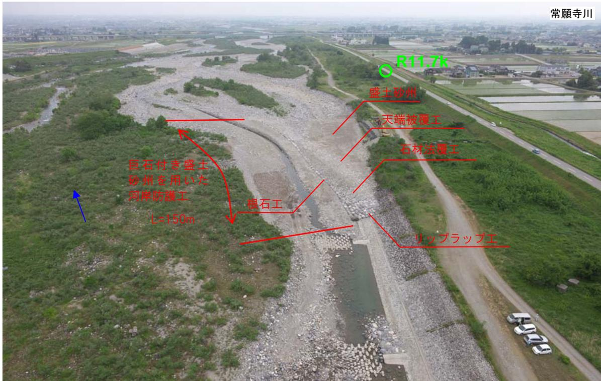
図 3.3.2 巨石付き盛土砂州を用いた河岸防護工（常願寺川右岸 11.7k）
