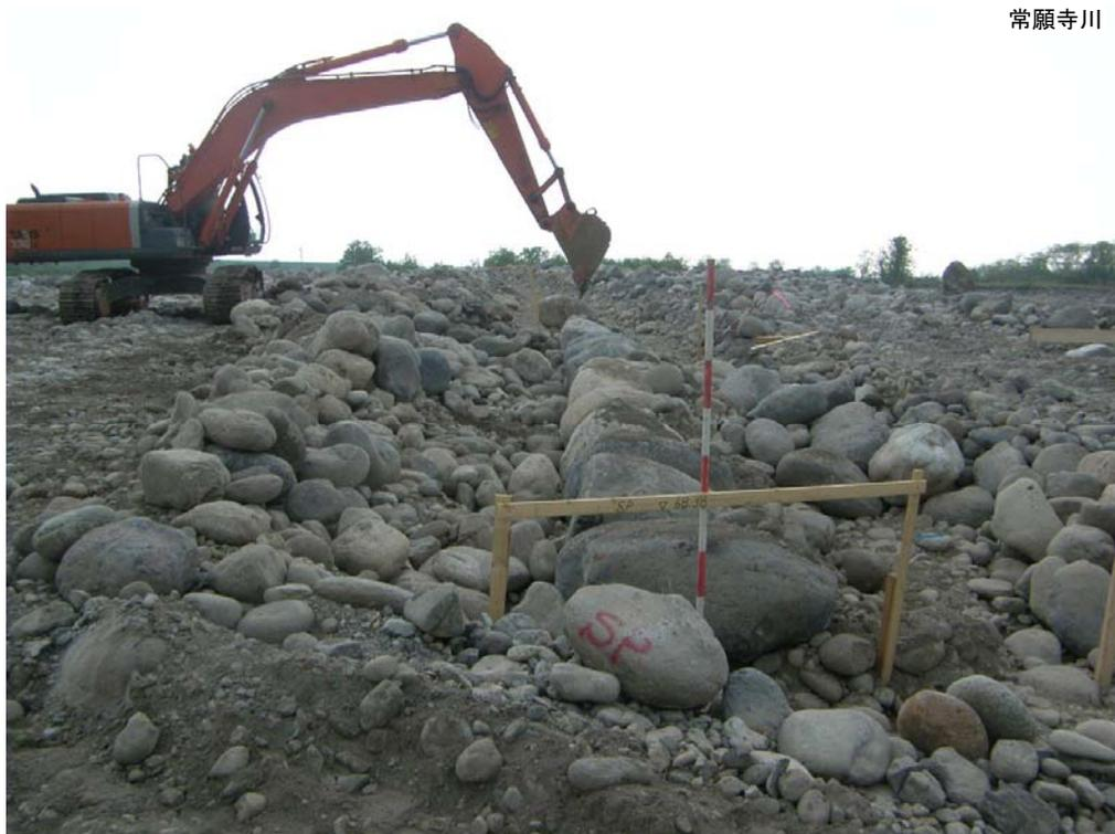
図 3.3.24 根石工施工状況
