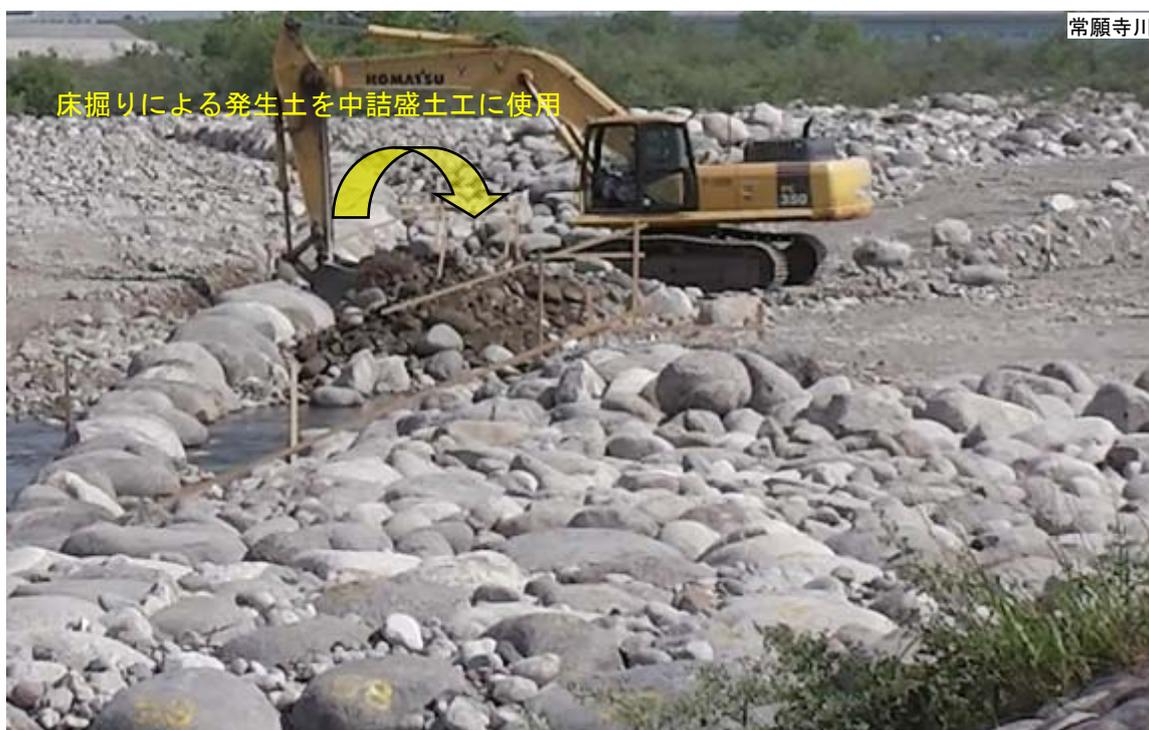
図 3.3.13 根石工床掘り時の現地発生材を使用した中詰盛土工の施工状況
