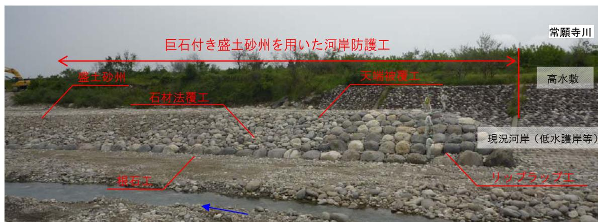
図 3.3.1 巨石付き盛土砂州を用いた河岸防護工（常願寺川 右岸 11.7k）
