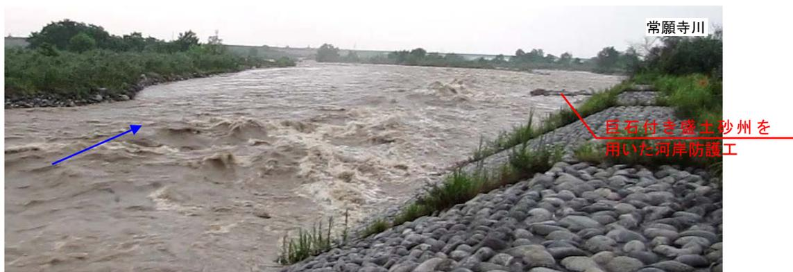
図 3.3.5 出水状況（巨石付き盛土砂州を用いた河岸防護工の天端高以上の水位）
