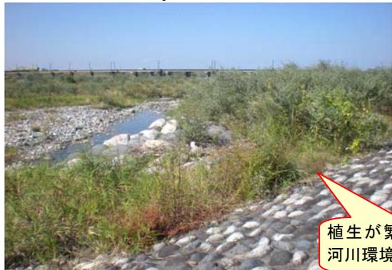
図 3.1.9 右岸7.1kの巨石付き盛土砂州を用いた河岸防護工の経年変化
