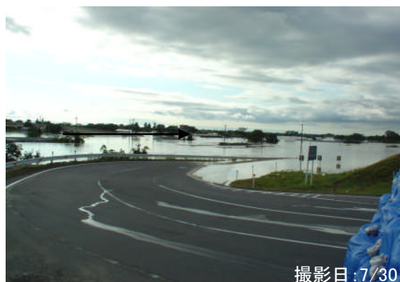
水防対応箇所に河川水が迫る
