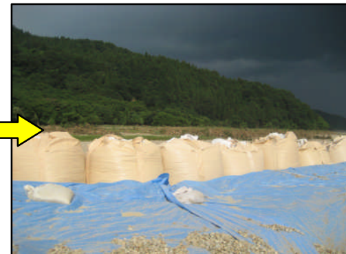
五十嵐川(三条市下田地区):大型土のう+砂利+ブルーシートによる越流防止措置
