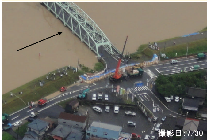
ヘリからの作業状況
