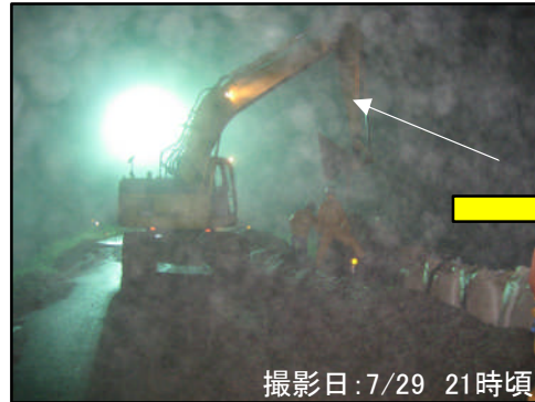
五十嵐川(三条市下田地区):大型土のう+砂利+ブルーシートによる越流防止措置
