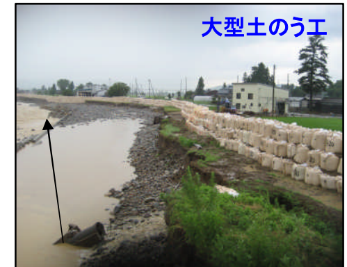
三条市江口地先 堤防決壊箇所
