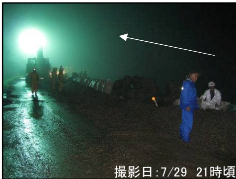
五十嵐川(三条市下田地区):大型土のう+砂利+ブルーシートによる越流防止措置
