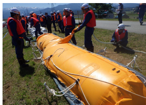
水のうマット工
