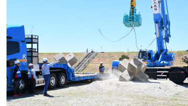
TEC-FORCEパートナー による応急復旧作業
