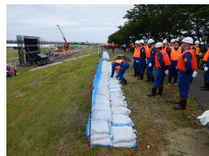
改良積み土のう工
