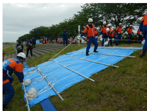
シート張り工
