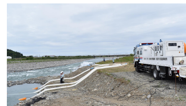
TEC-FORCE（排水ポンプ車） による湛水排除訓練
