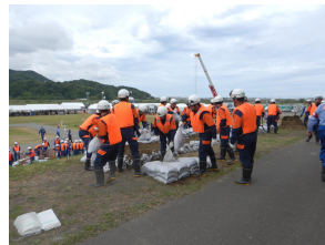
積み土のう工
