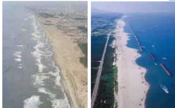
離岸堤の施工前と施工後(新潟海岸)
