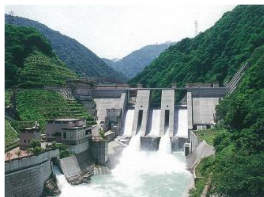
完成直後の宇奈月ダム
