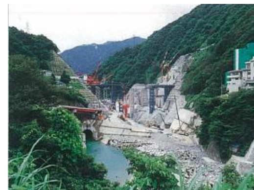
建設中の宇奈月ダム (H5.7)
