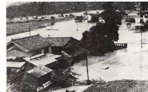
愛本付近の浸水状況
