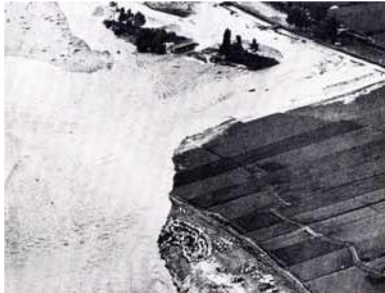
黒部川右岸入善町福島の破堤状況（増水中）
