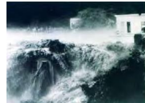
愛本堰堤管理橋
