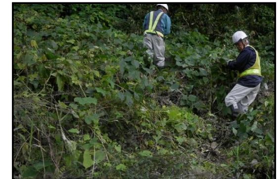
除去作業状況
