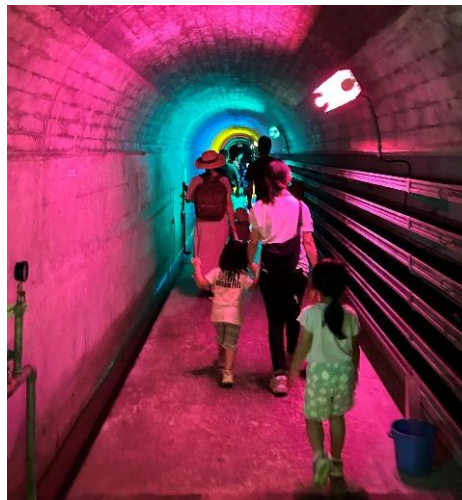
大川ダム（監査廊見学）
