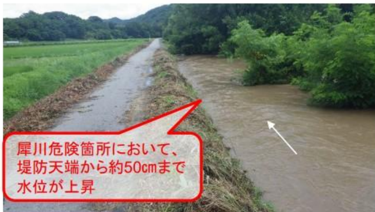
出水状況①（犀川左岸59k付近安曇野市塩川原地先）
