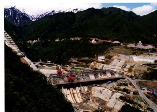
建設中の大町ダム
