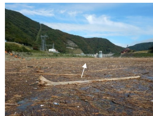
貯水池内の流木
