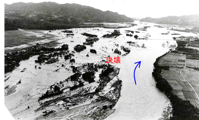
関川村の浸水状況
