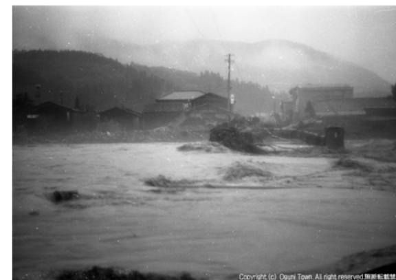
氾濫に巻き込まれる小国大橋
