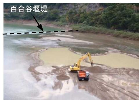
掘削積み込み状況
