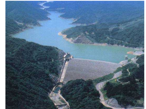
手取川ダムの外観
