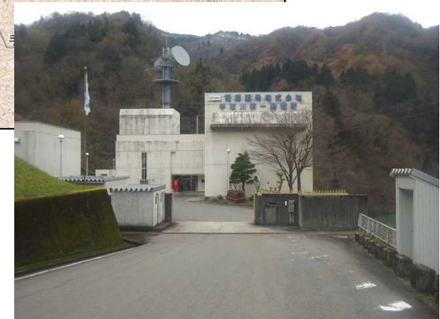
手取川第一発電所
