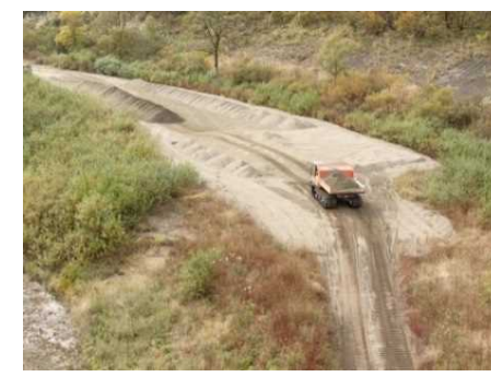
掘削土運搬 (仮置き抜水後に積み込み搬出)
