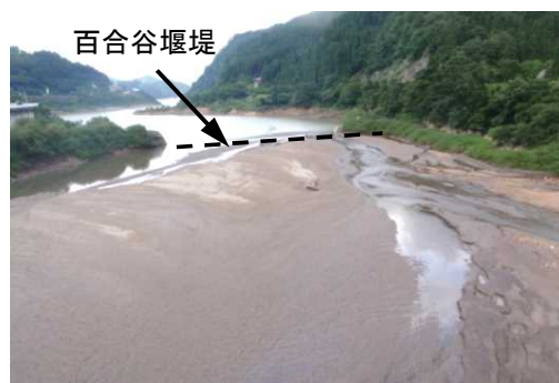
百合谷堰堤堆砂状況
