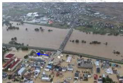
飯山市(中央橋左岸)の浸水状況
