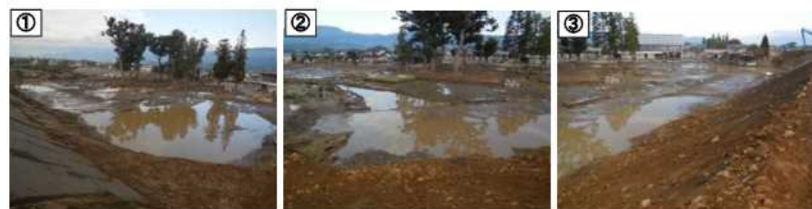
図 4.2.42 落堀、洗掘削の状況 (2019(令和元).10.18 7:20 頃撮影)
