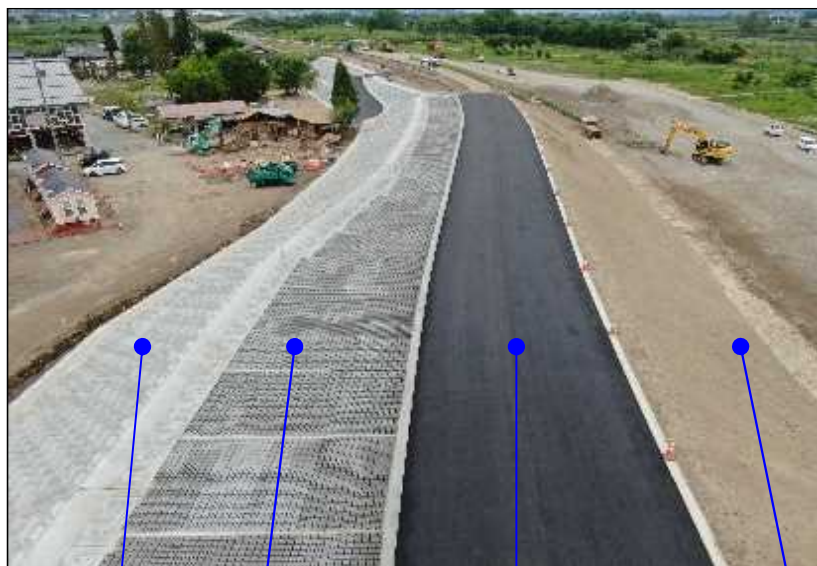
(写真) 施工状況
