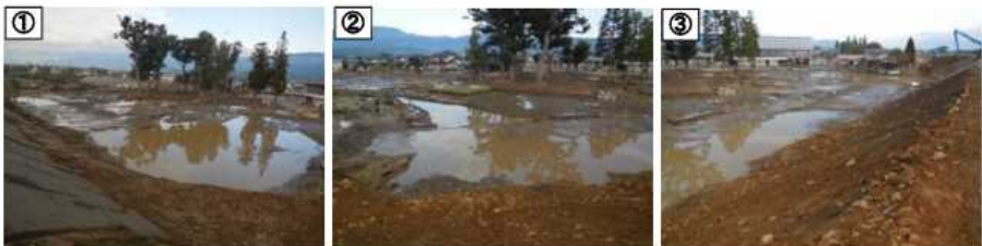
図 4.2.42 落堀、洗掘削の状況 (2019(令和元).10.18 7:20 頃撮影)
