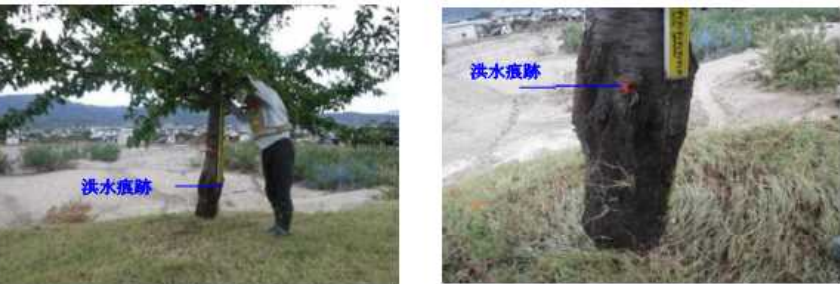
図 4.2.37 ①左岸 57.5k 地点 洪水痕跡
