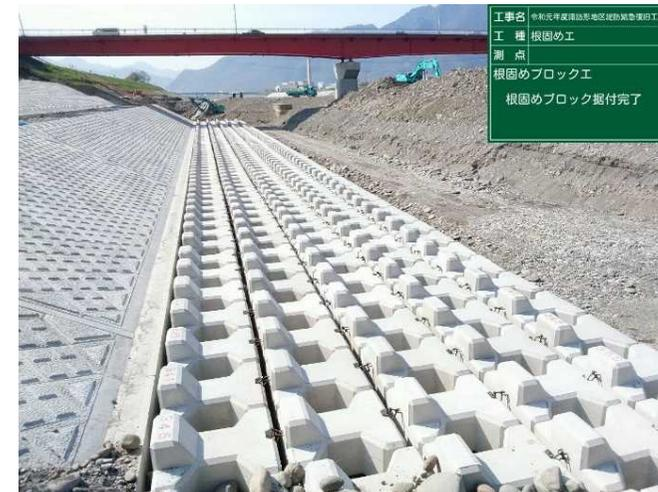
根固めブロックの施工完了写真
