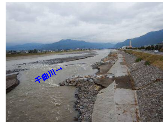
上田橋右岸側下流(10月21日撮影)
