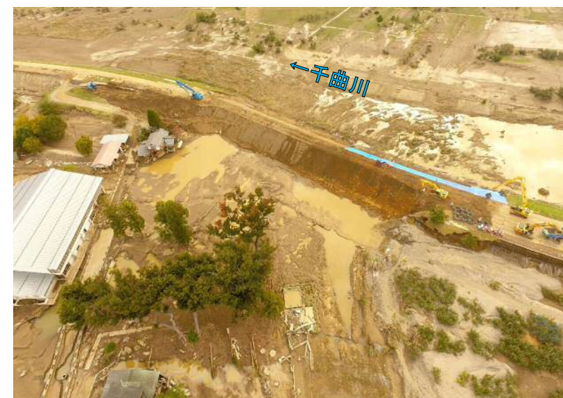
図-4 測量時空撮・仮堤防完成時 (2019. 10. 18撮影)
