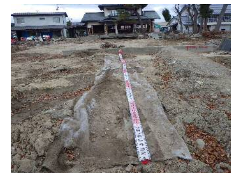
⑧流失した吸出防止材状態確認
