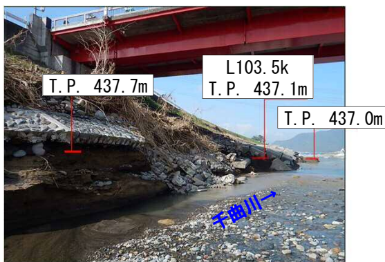
上田橋下流(10月31日撮影)
