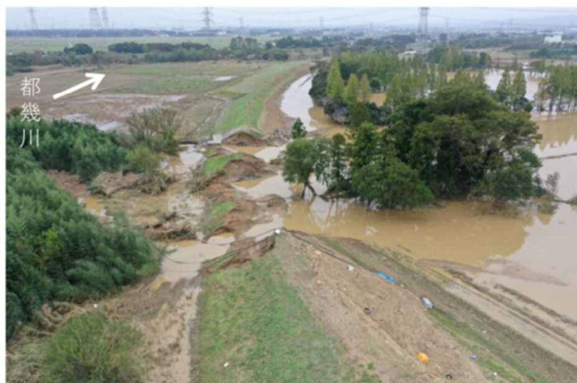
都幾川0.4k右岸 決壊箇所
