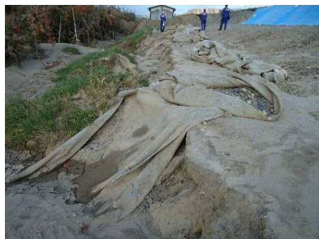
①法尻付近に残存する吸出防止材
