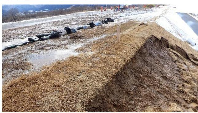
崩落上の枕土嚢前に大きな水溜りができる
