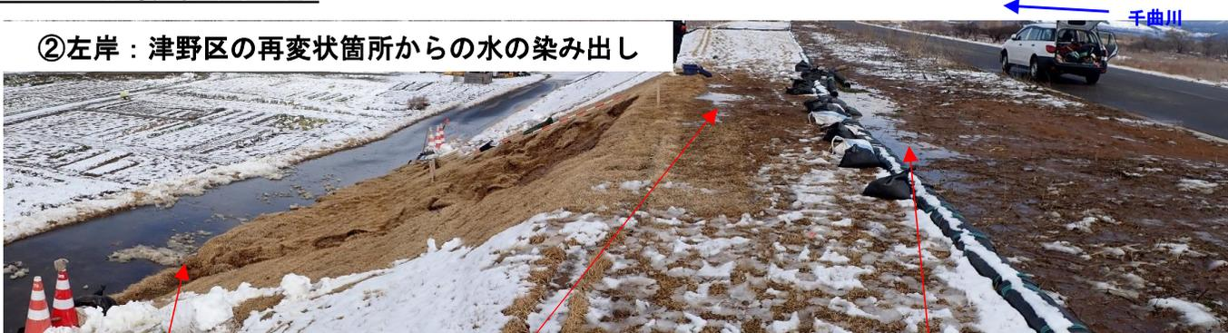
末端部では崩積土から水が染み出している
