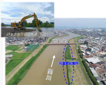
一級河川関川における河道掘削工事 (藤野新田地区)
