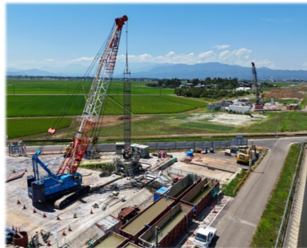
上越三和道路(橋梁下部工事)
