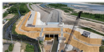
【河川事業】西川・熊田川合流点処理事業
