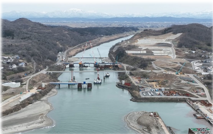
令和の大改修「大河津分水路」（新潟県）
