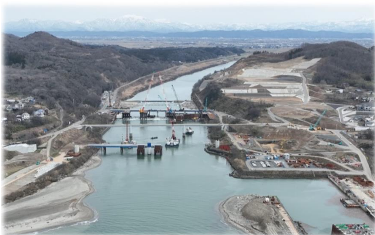
令和の大改修「大河津分水路」（新潟県）
