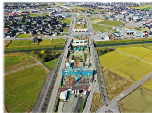
[国道8号 六家立体]
