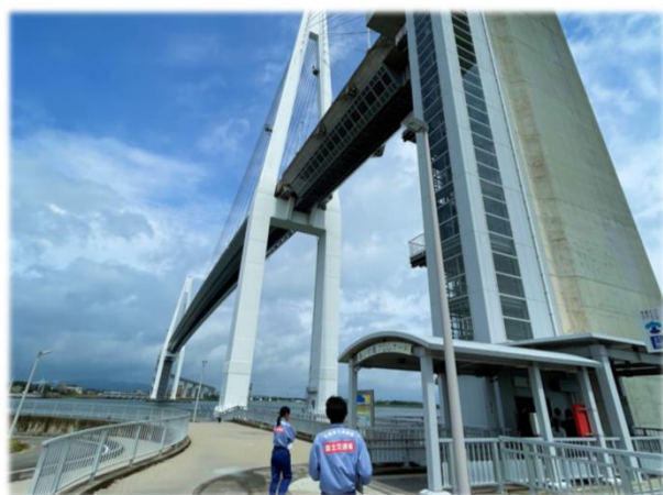
[大規模な土木施設の見学]
