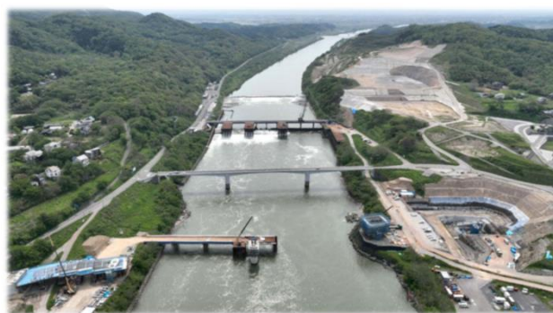
[大河津分水路 工事状況(下流から上流を望む)]
