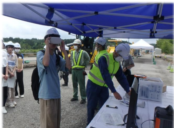
〔AR・VRによる工事現場の説明〕
