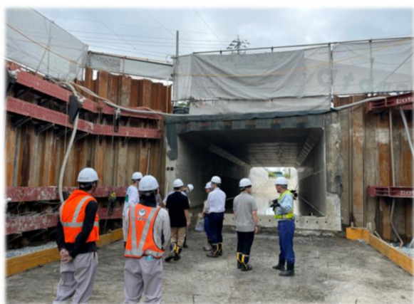
〔大規模な工事現場の見学〕
