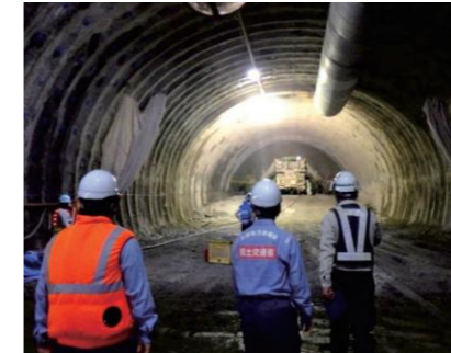
トンネル工事見学
