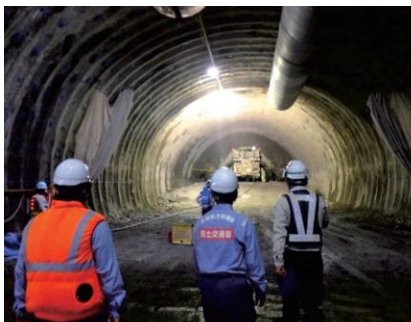
トンネル工事見学
