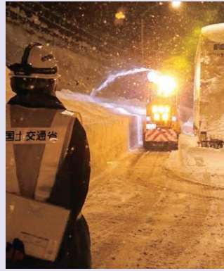
令和2年12月雪害 除雪車による除雪支援（関越自動車道）
