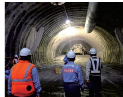
トンネル工事見学
