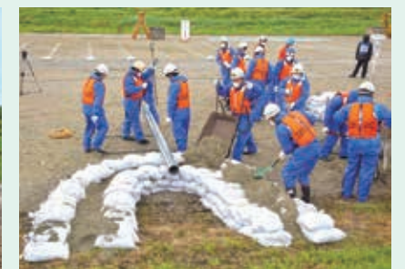
水防団による水防訓練（月の輪工）
