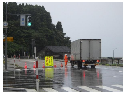
なかなみ あお 国道160号 中波・阿尾通行止め (8月27日4:40～28日9:00 規制時間28:20)
