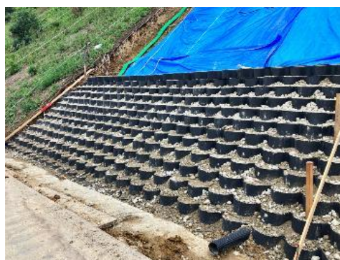
今回施工を予定している法面保護対策
